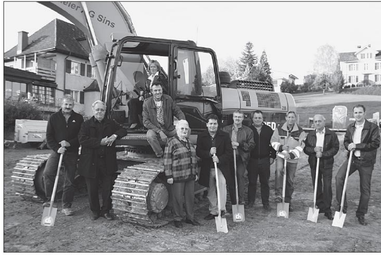
Vertreter von Bauherrschaft, Architekten, Gemeinde, von Unternehmern und Nachbarn beteiligten sich am Spatenstich der Überbauung «am Bach». Bild: rico
