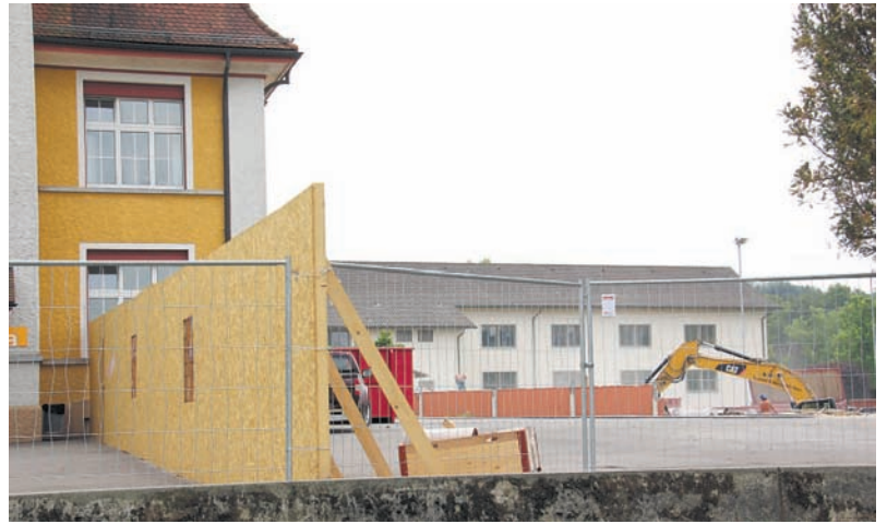
Das gesamte Bauareal wurde sicher abgesperrt. Bild: Beatrice Rüttimann-Hug
