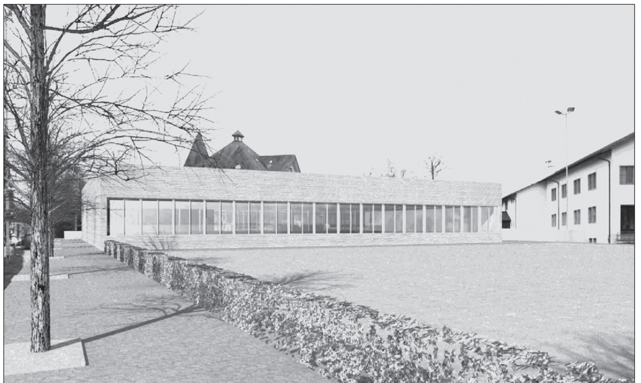
Im Ammannsmattareal entsteht Platz: In der 1. Etappe kommt die neue Mehrzweckhalle.
