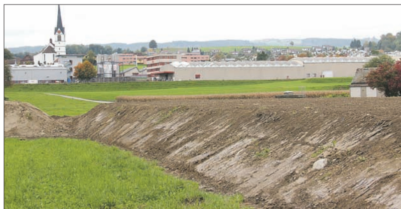
Rund um das Pumpwerk Staadmatt im Sinsler Schachen wurde das Terrain um 1,60 Meter angehoben, um den erforderlichen Hochwasserschutz zu garantieren.
