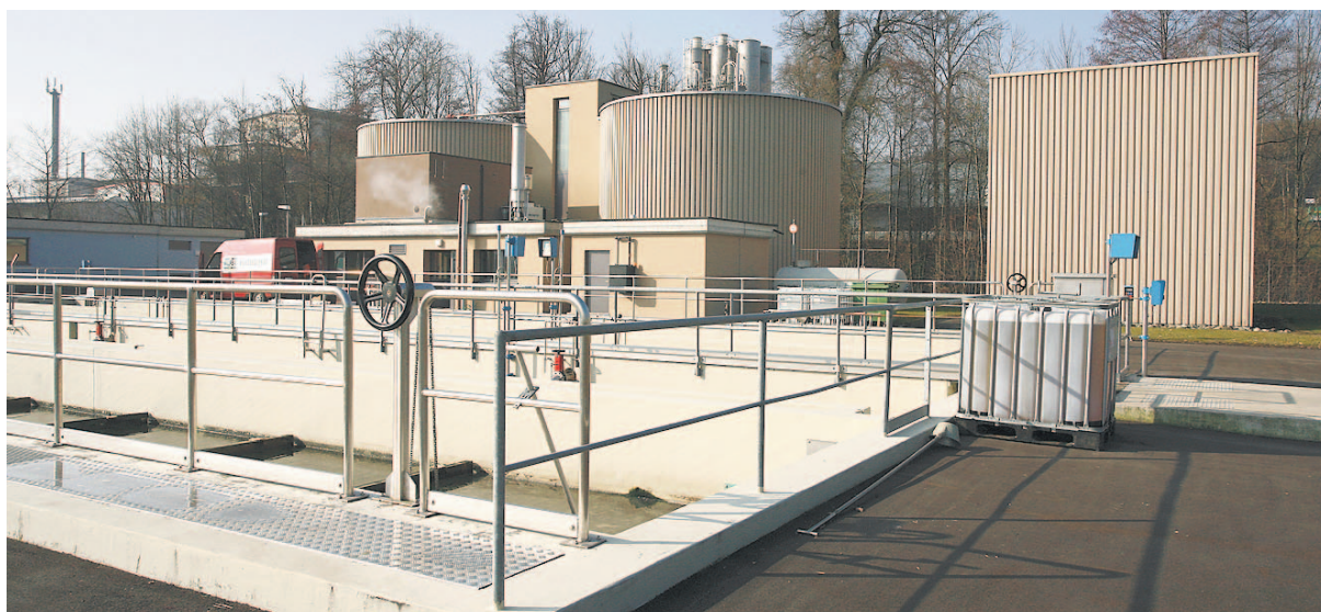
Heizenergie aus dem Industriegebiet: Für den Antrieb der Wärmepumpen des Wärmeverbunds Sins sollen die Abwärme der ARA (Bild) und das Grundwasser der Airex AG genutzt werden. Bild: Heinz Abegglen
