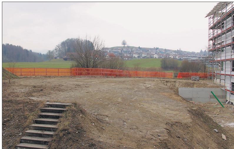
Zwischen dem Zentrum Aettenbühl und den rechts im Bau befindenden Alterswohnungen, wird der Dementengarten entstehen.
