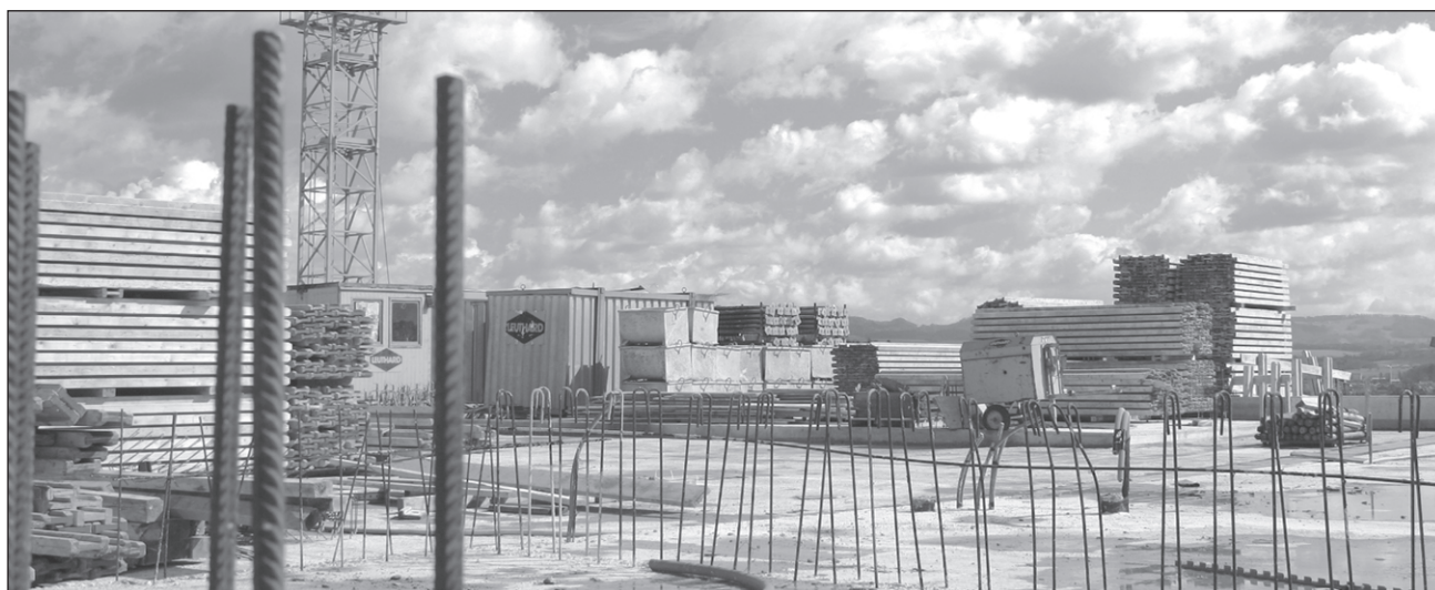
Auch wenn vielerorts gebaut wurde und fortlaufend neue Wohnhäuser in den Himmel wachsen, liegt das Bevölkerungswachstum im Freiamt nur wenig über dem Kantonsdurchschnitt. Bild: Andreas Kaufmann
