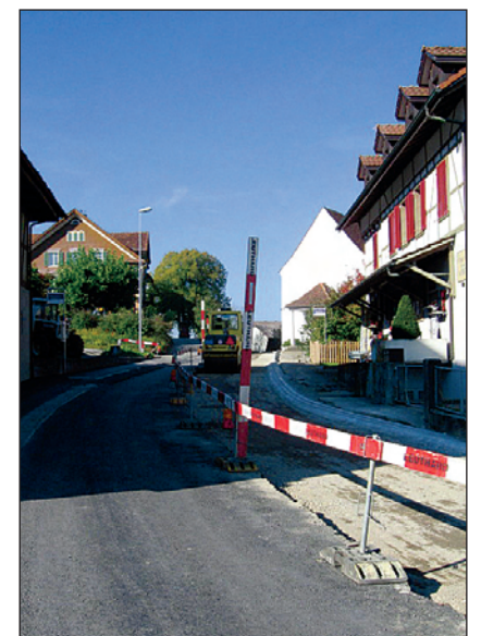
Die Baustelle durchs Dorf ist bald Vergangenheit.
