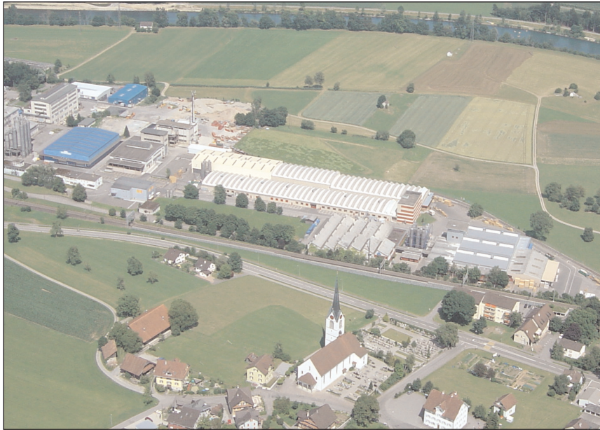
Flugaufnahme der Alcan Airex AG (Bildmitte) im Sinser Industriequartier Nord. Bild: zVg
